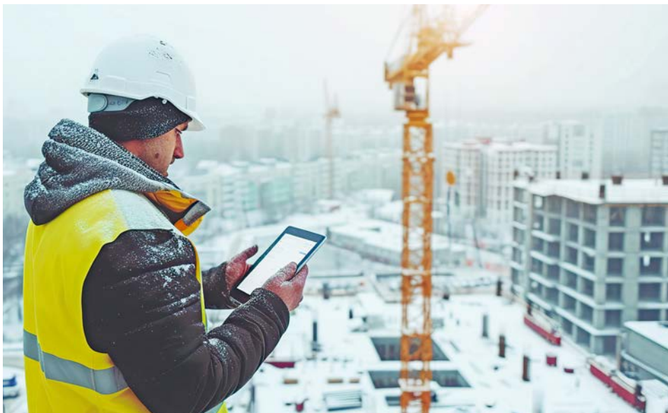
Baustellen sind oft lästig, sie ermöglichen aber auch Neues, Schöneres.
